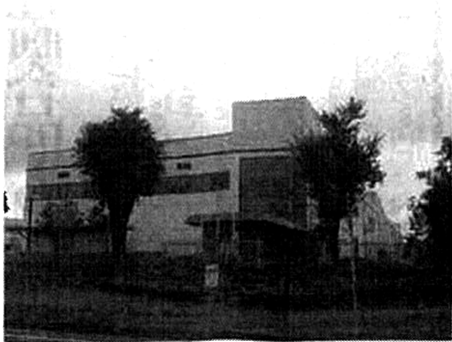
那珂工場の外観
